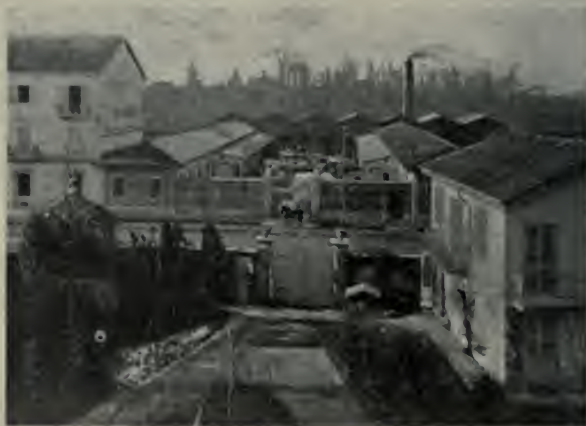
VEDUTA GENERALE DELLO STABILIMENTO.
